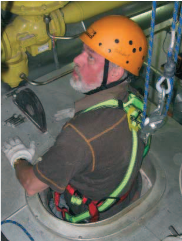
Einstieg in Druckbehälter © R. Schubert
